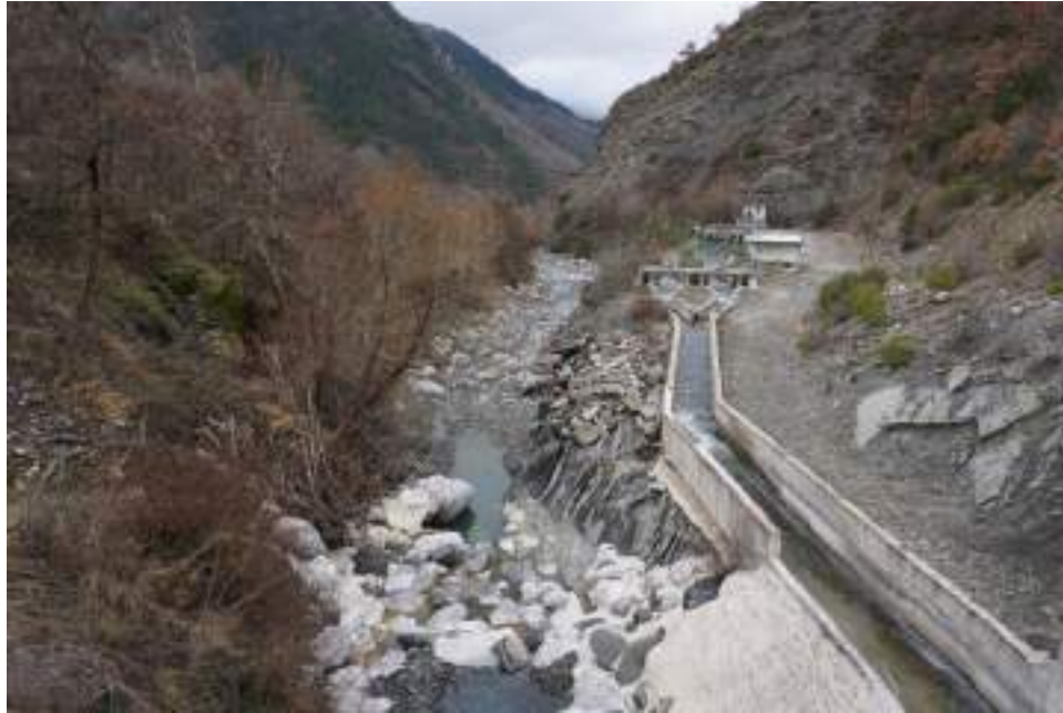
Εικόνα 15: Τα τεχνικά έργα υδρομάστευσης στο φράγμα του ΜΥΗΕ στο ρέμα Βουρκοπόταμου. © Φ.-Ν. Σακελλαράκης/MedINA.
